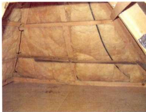
Фиг. 2 Изображение отвътре, показващо стъклена вата поставена върху гредите
