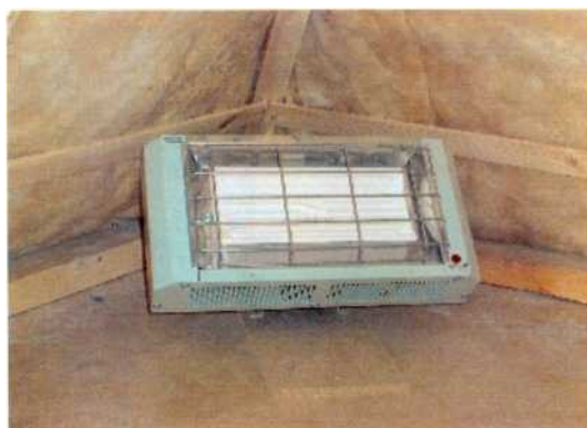
Фиг. 8 Разположение на керамичния отоплител
